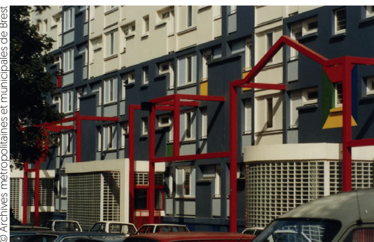
Rue de Kermenguy, façade des immeubles après la rénovation, 1990.
