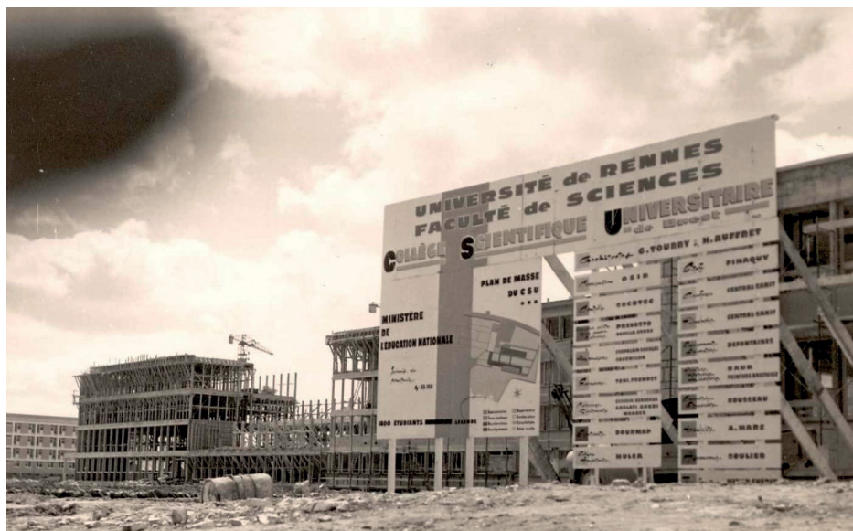
La faculté des sciences, agrandissement : le panneau de chantier et des bâtiments en cours de construction, 1970.
