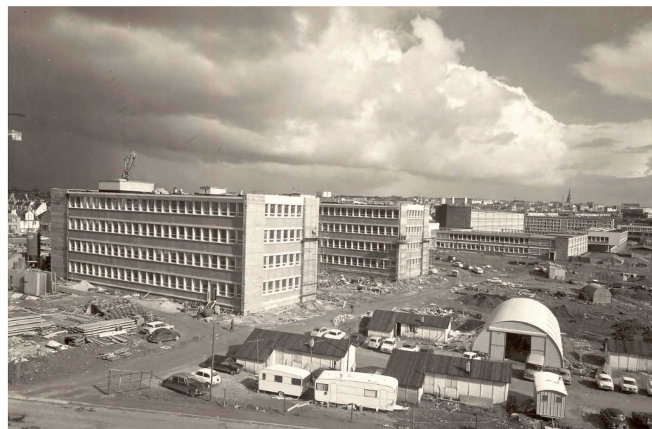
Extension de la faculté, avenue Victor Le Gorgeu. Les bâtiments en voie d'achèvement avec le reste des baraques qui servent pour le chantier et des caravanes de chantier, 1970.
