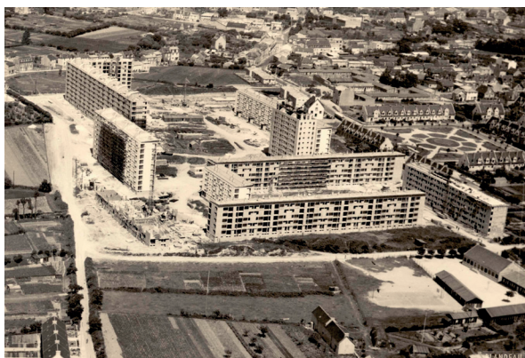
Vue aérienne, les immeubles en construction, les baraques, la place de Metz, 1960.
