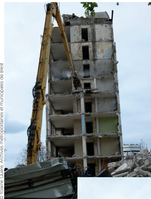
Démolition de l'immeuble du 37 rue de Kermenguy, 23 avril 2024.
