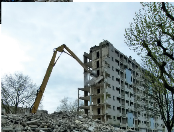
Démolition des immeubles du 37 au 43, rue de Kermenguy, 23 avril 2024.
