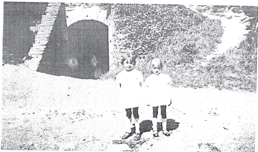
Entrée du tunnel conduisant aux douves, avant la construction des chicanes en terre.
