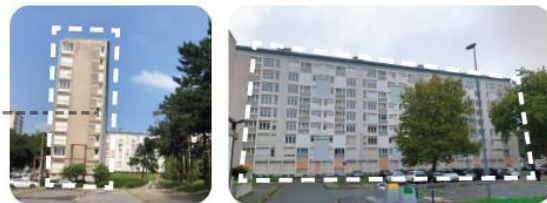
Démolition de 4 résidences.
