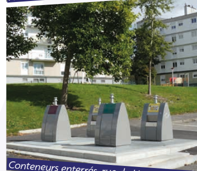
Arceaux vélo - Groupe scolaire Kerhallet
