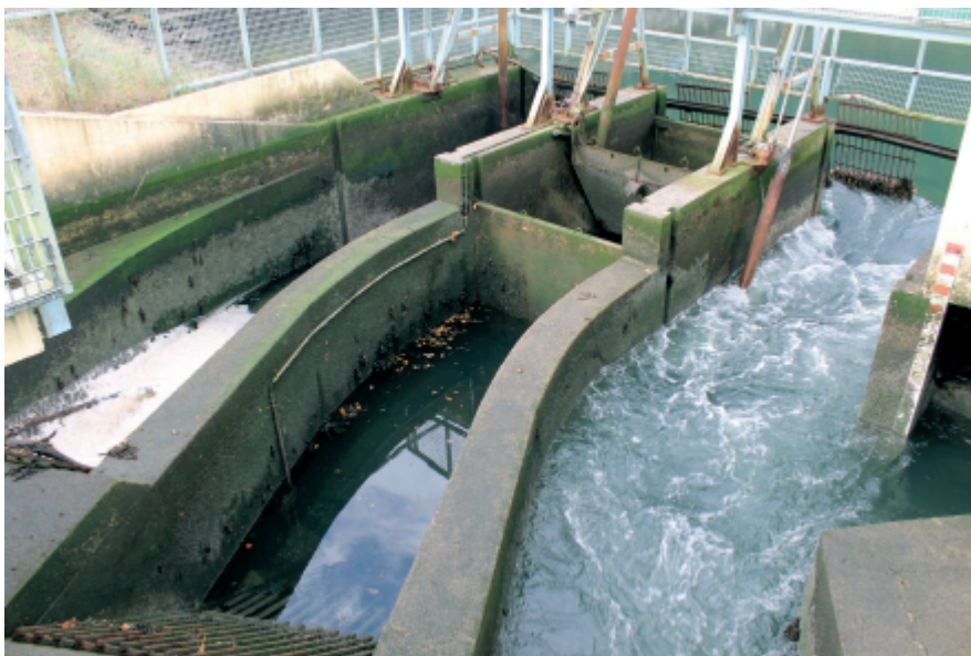
Les vannes avant les travaux, à la porte de l'Arrière-Garde
