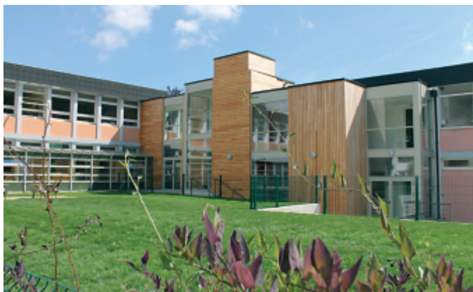
L'ascenseur nouvellement installé à l'école Dupouy
