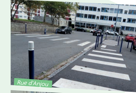
Travaux boulevard Europe - 4 vents
